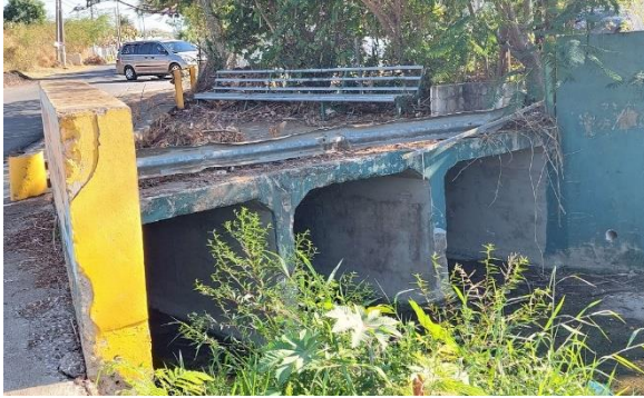
Foto 9 – Detalle del puente en la frontera este de la comunidad El Coquí . Nótese los entorpecimientos de la estructura al libre fluir de las aguas.
