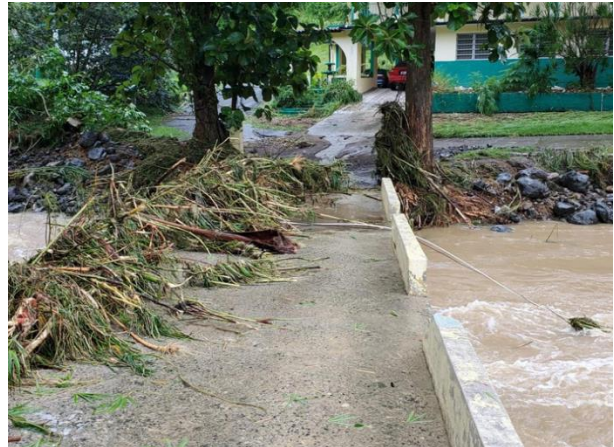
Foto 12 – Acumulación de escombros vegetales en puente de la comunidad El Coquí , según transportados por la corriente.
